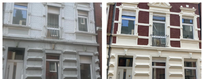
Beispiel Fassadensanierung Johanna-Neuman-Straße
